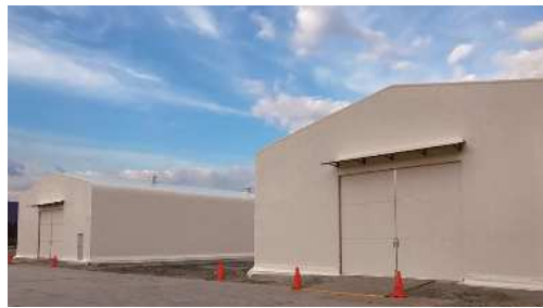
施工例：テント倉庫
