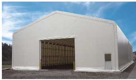
施工例：テント倉庫
